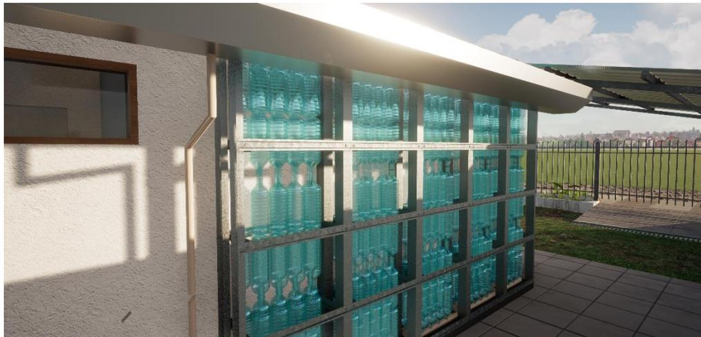
La instalación se completa con la colocación de la canaleta con rejilla, la bajante y su extensión para el separador de primeras aguas y la conexión de una tubería de rebose en la parte superior. Para la estructura de soporte se coloca una pequeña base de concreto y perfilaría metálica.
